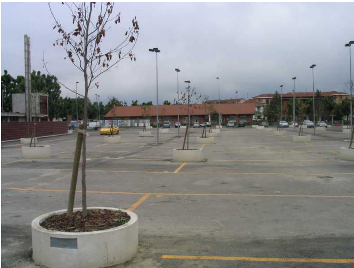
S.Mauro torinese - mercatale (in cantiere)
